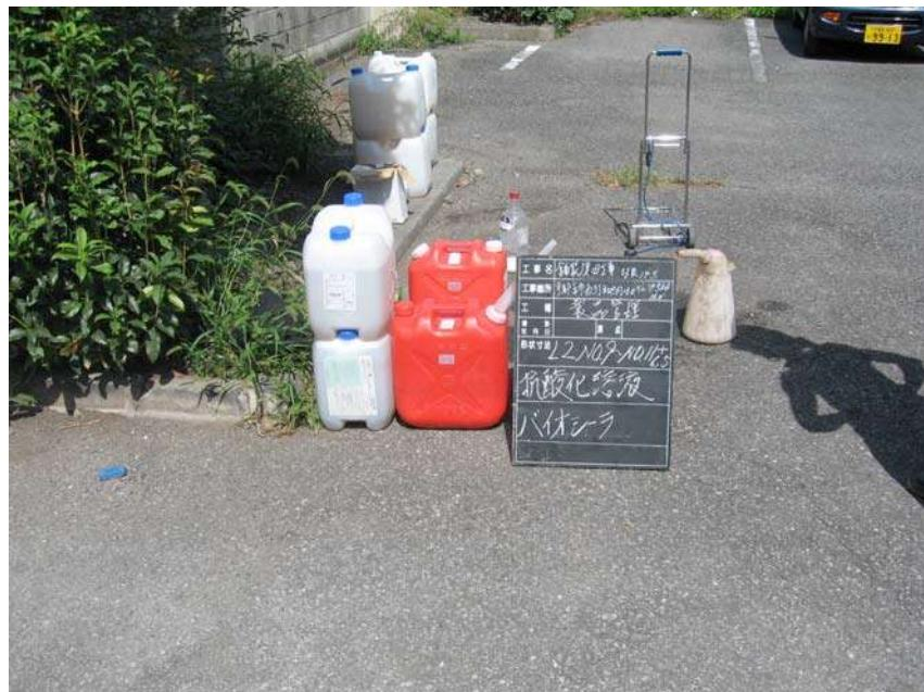
アスファルト施工前にバイオシーラー+セラミック水を舗装面に散布。
