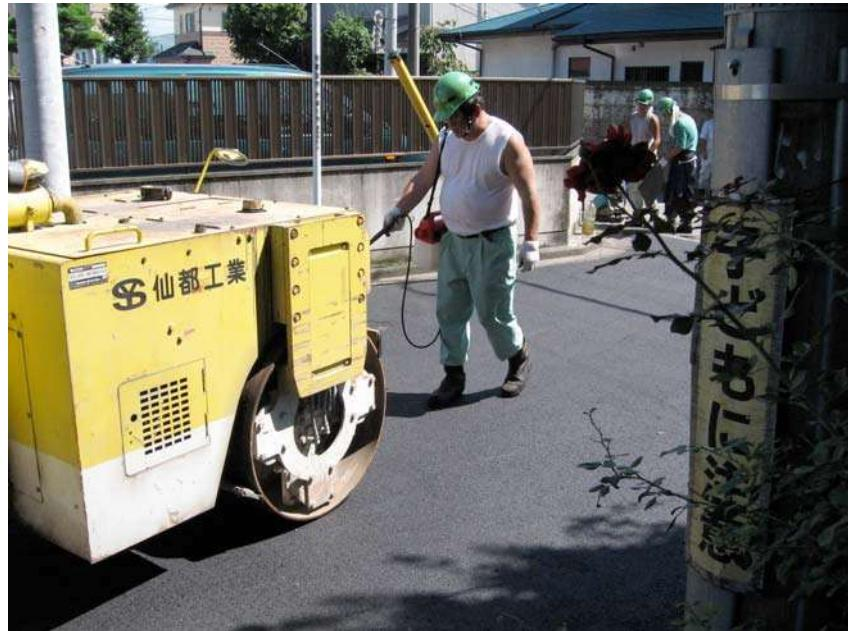
施工後に「えみな水溶液」(1/1000希釈)を散布
